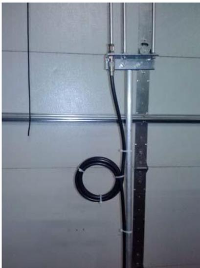
Enfin, la mise à la terre de l'antenne n'est pas nécessaire pour les performances. Mais elle peut être mise à la terre pour la protection contre la foudre en mettant à la terre le support d'assemblage. Cela n'affectera pas les performances.
